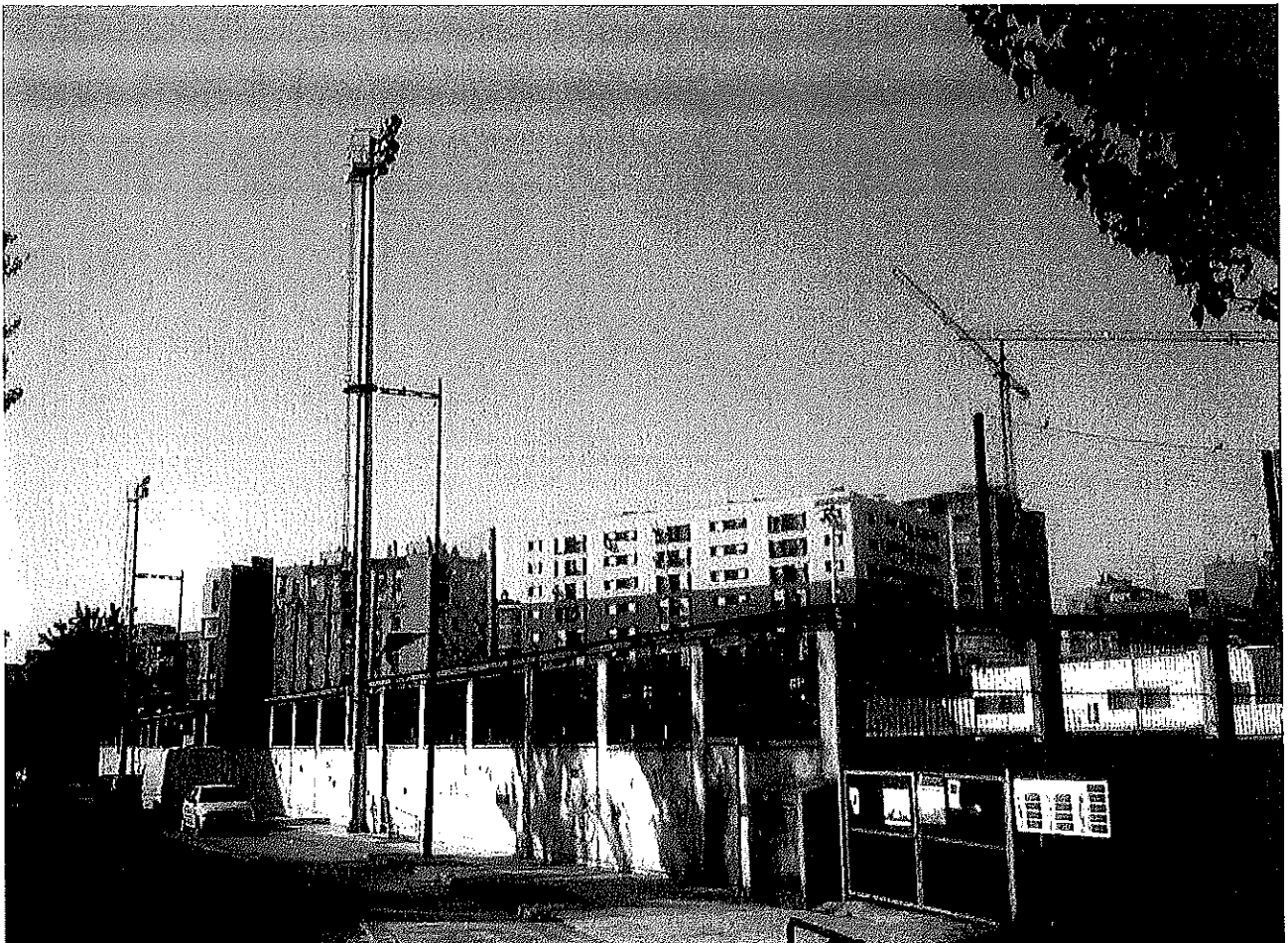
Fotografía final de obra
